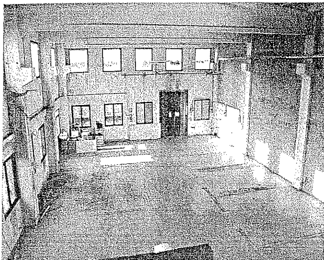
– Foto 1 – interni dal soppalco
